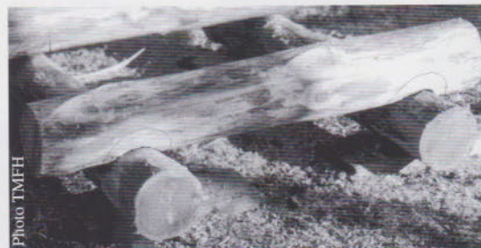
76 Sur cette photo, l'ébauche a déjà été réalisée sur C1, qui, après avoir été remis en place, a été tracé pour la découpe de l'entaille définitive.
