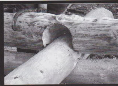
... pour que l'emboîtement se fasse sans forcer... L'ajustage est réussi...
