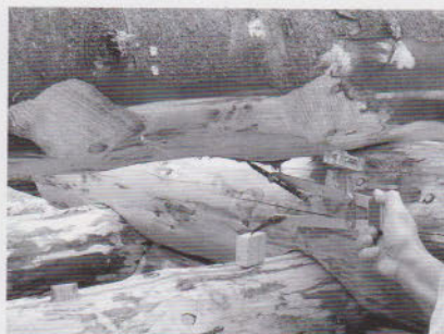
(9) Mesurer avec une cale de 5 cm
