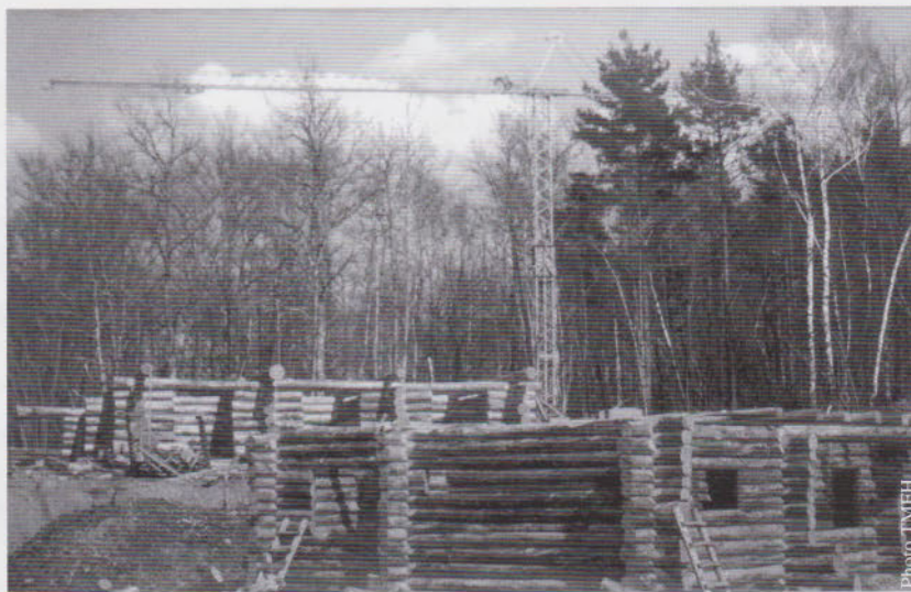
Chantier de construction de fustes en pleine forêt (BCN)
