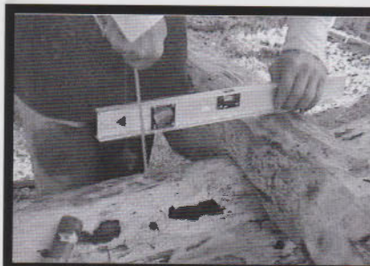
Avant de choisir un bois, mesurez les niveaux et les hauteurs de tête.
