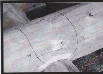
La découpe des joues verticales (les épaulements) sur le rondin du dessous.
