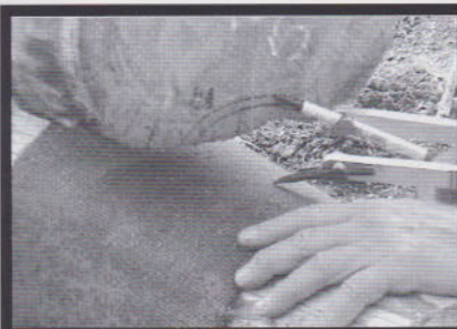
Tracer en bout la goulotte. Un bout de moquette permet de « surtracer » pour le jeu en bout.
