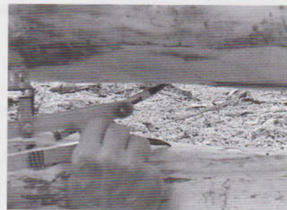
(13) Mesurer avec le compas l'espace le plus large (traçage final)
