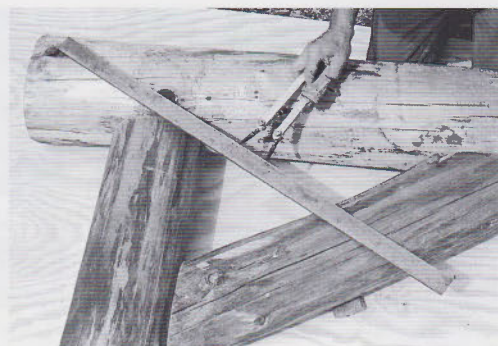
(5) Tracer parallèlement à une direction oblique
